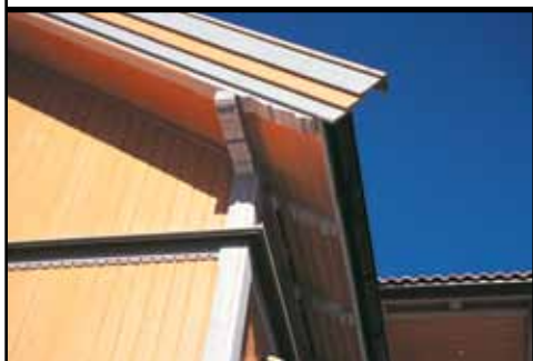
Tak med sperreføtter (58x115mm) og uthengsperrer (58x115mm).
